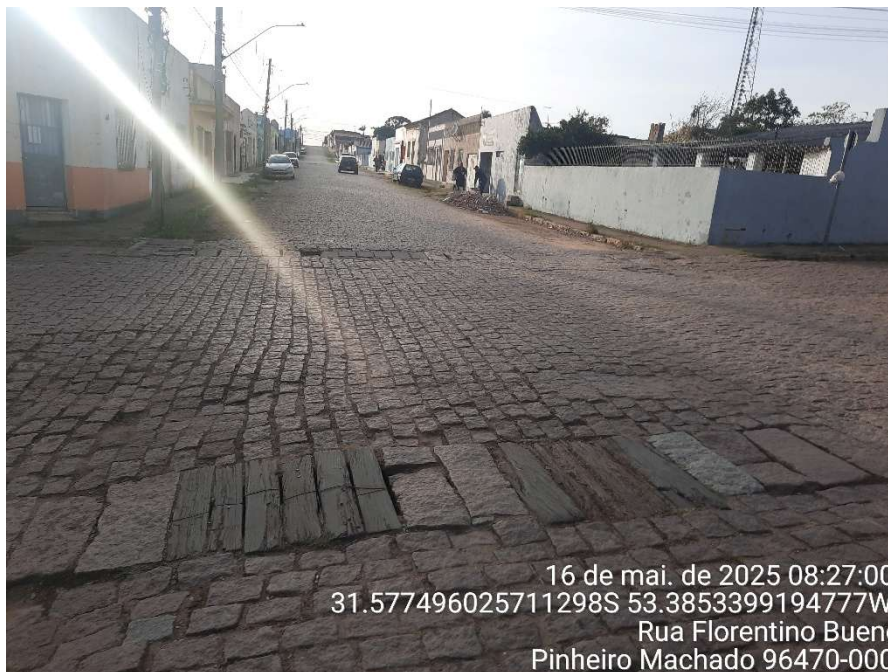
Exemplos de locais a serem substituído as lajes existentes
