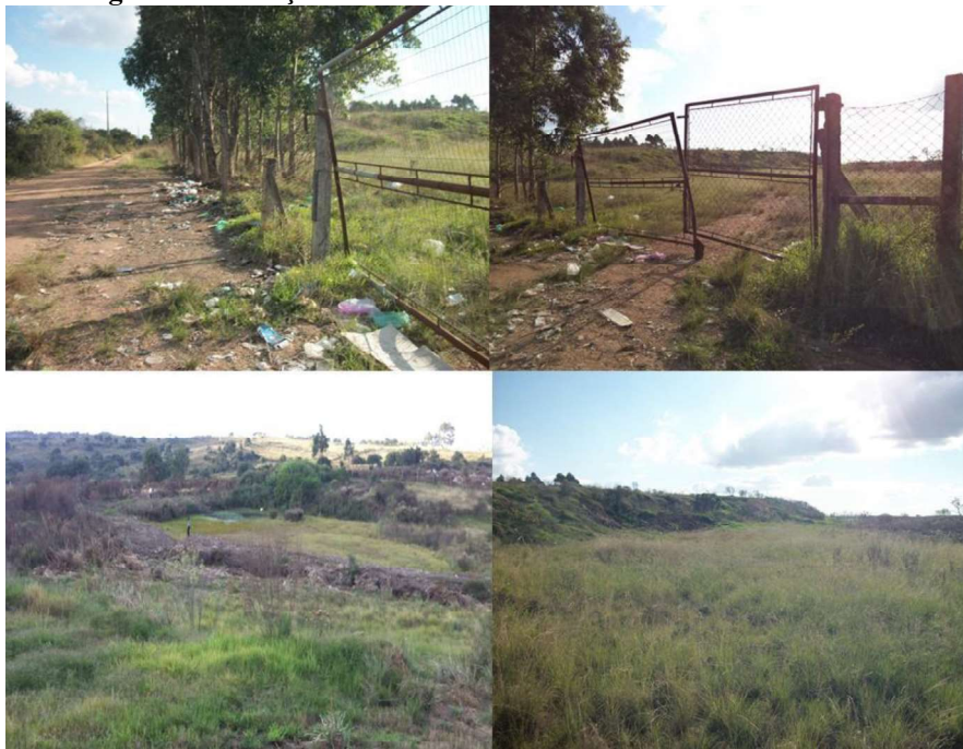
Figura 5 – Situação do aterro controlado desativado
