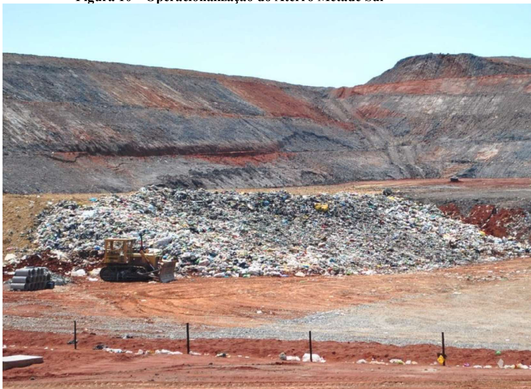
Figura 10 – Operacionalização do Aterro Metade Sul
