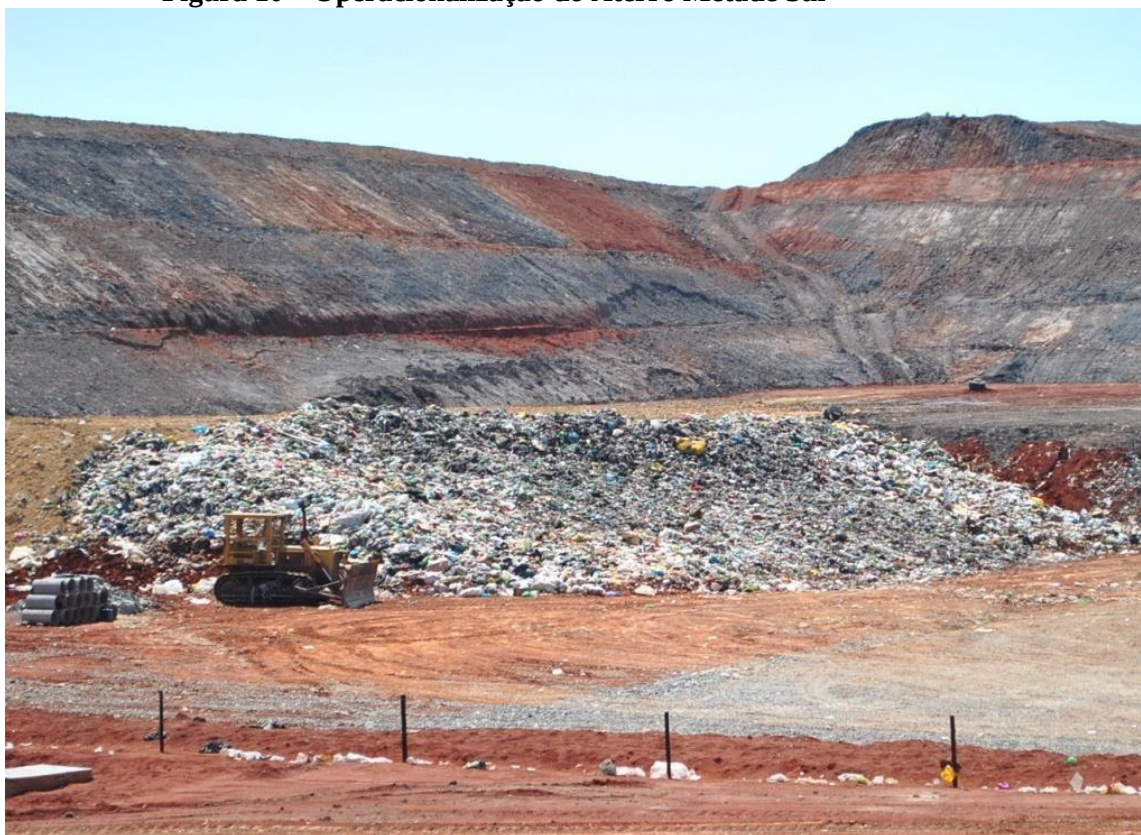
Figura 10 – Operacionalização do Aterro Metade Sul
