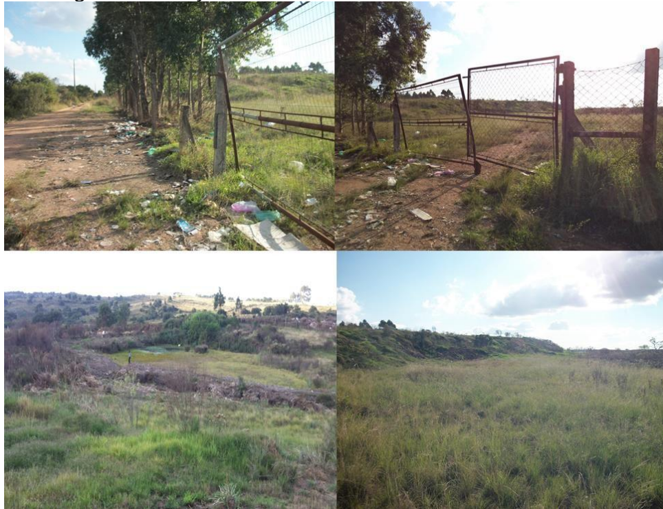
Figura 5 – Situação do aterro controlado desativado
