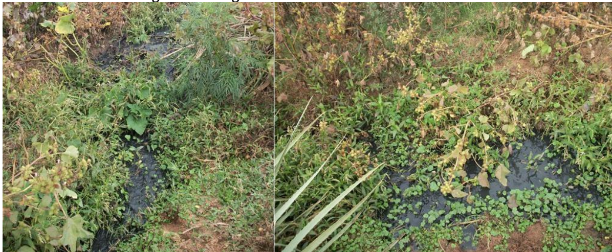
Figura 25 – Esgoto a céu aberto em Pinheiro Machado
